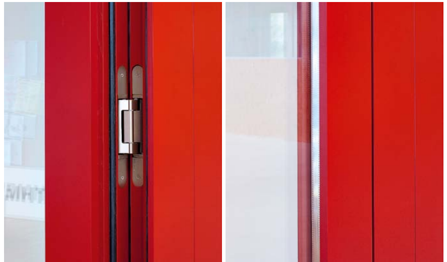
Verdeckt liegende „Tectus“-Bänder von Simonswerk (links) binden die Türen in die flächenbündige, minimalistische Architektur der Werkshalle ein.
