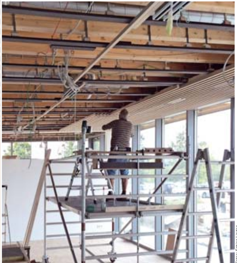
Die Multiplexleisten sind von oben auf Stoß durch abgehängte MDF-Streifen geschraubt. Sie tragen Dämmplatten aus kaschierter Mineralwolle
