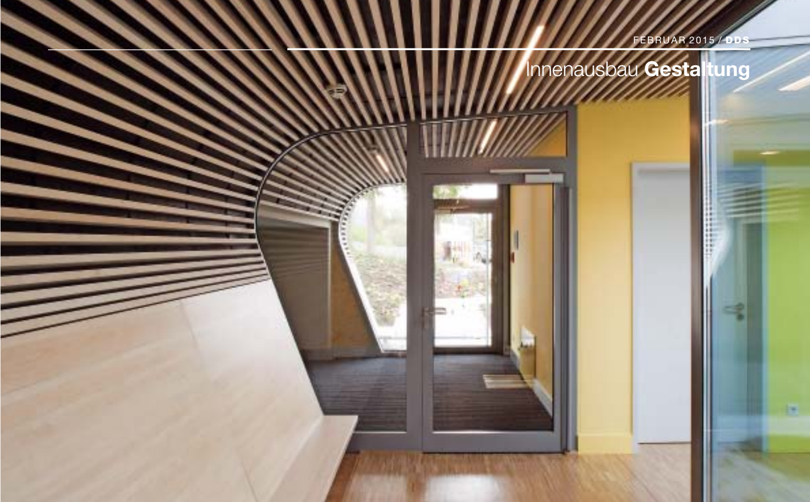
Eingangsbereich mit Kinderwagengarage im Spielflur der neuen Gira-Betriebskita. Mineralwolle auf Multiplexleisten schluckt den Schall
