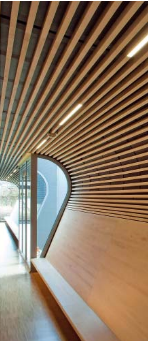
Im langen Spielflur geht die Deckenverkleidung in eine Bank über: Die Abstände der Leisten verdichten sich
